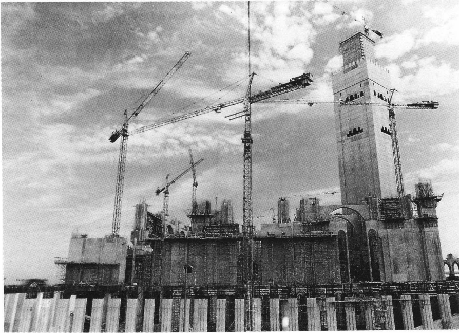
La grande mosquée de Hassan II en cours de construction.
